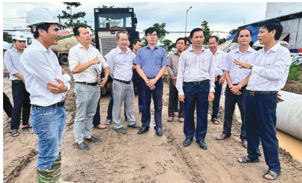
Đồng chí Lâm Văn Mẫn - Ủy viên Ban Chấp hành Trung ương Đảng, Bí thư Tỉnh ủy, Trưởng Đoàn đại biểu Quốc hội tỉnh Sóc Trăng (bìa phải) trao đổi với nhà thầu thuộc Dự án đường Vành đai II, thành phố Sóc Trăng. Ảnh: THẠCH PÍCH
