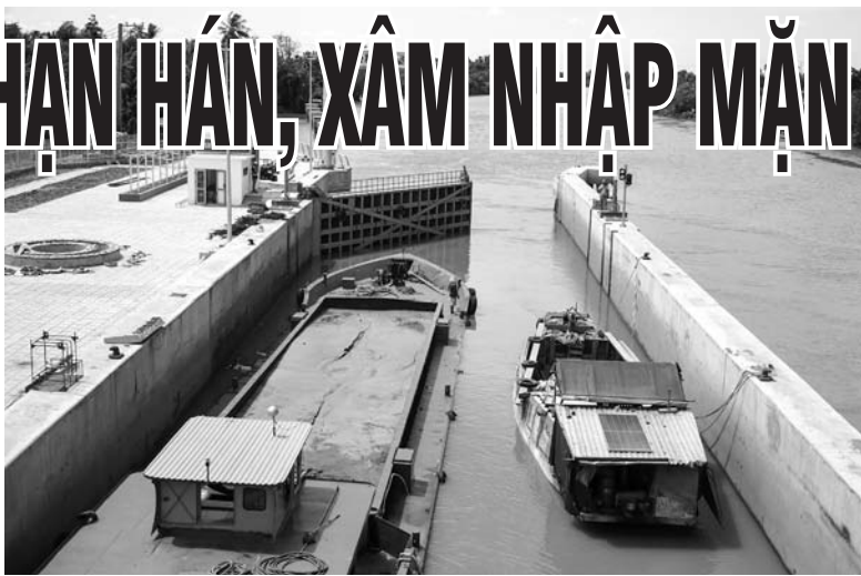
Cống âu thuyền Rạch Mọt, thuộc địa bàn 2 huyện Kế Sách và Long Phú hoàn thiện đi vào vận hành, góp phần ứng phó xâm nhập mặn cho nhiều địa phương trên địa bàn tỉnh Sóc Trăng. Ảnh: THÚY LIỄU
