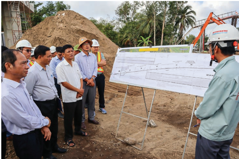
Lãnh đạo tỉnh Sóc Trăng khảo sát thực tế tiến độ công trình. Ảnh: QUANG BÌNH
