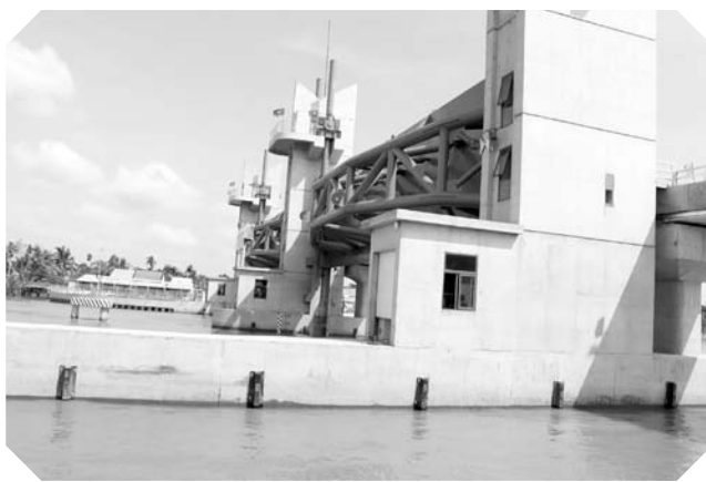
Cổng âu Rạch Mộp giúp giảm thiểu thiệt hại do hạn, mặn; chủ động cấp nước ngọt cho trên 36.700ha ở tỉnh Sóc Trăng và tỉnh Hậu Giang. Ảnh: THÚY LIỄU
